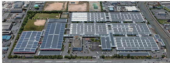
メガソーラー設備によるエネルギーの創出
