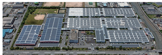
メガソーラー設備によるエネルギーの創出
